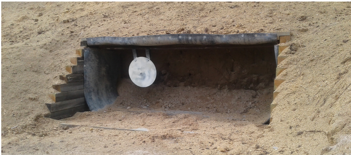
Bild 3:5. Kulfång med ingrävt splitterskydd för metallmål
