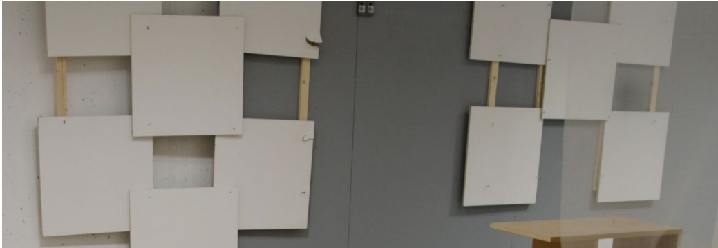
Bild 7:4. Hur man kan nyttja takabsorbenter för att minska tryckpåverkan.
