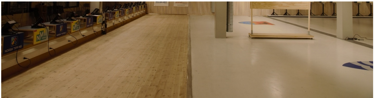
Bild 7:3. Golvet närmast skjutplatsen har förstärkts för att minimera rikoschettrisken.
